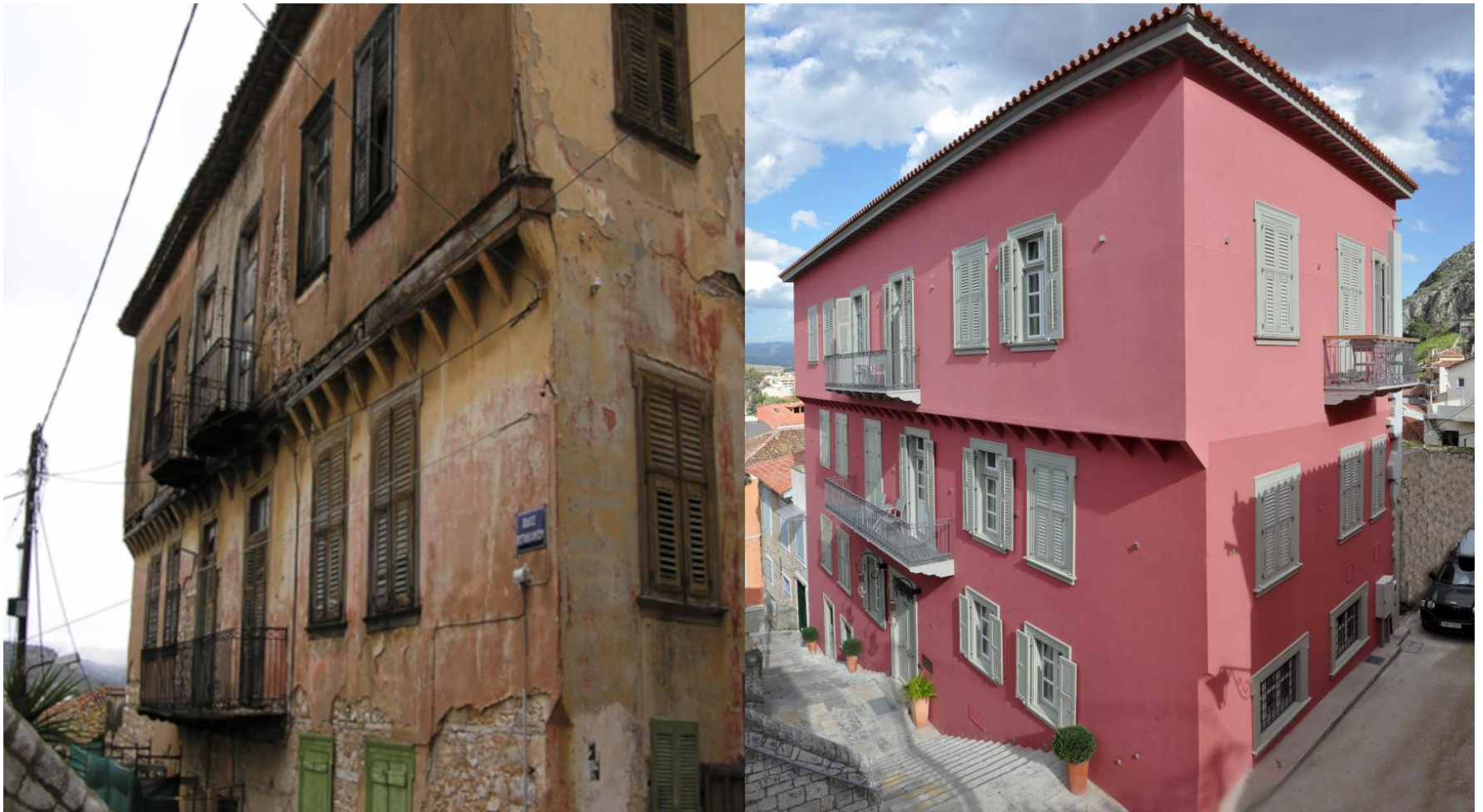
Ναύπλιο: Το κτίριο στο οποίο στεγάστηκε το Λογιστικό και Ελεγκτικό Συμβούλιο από το 1829 έως το 1835 πριν (αριστερή εικόνα) και μετά (δεξιά εικόνα) την αναπαλαίωση το 2000
