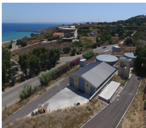
Εικόνα 10: Εξωτερική άποψη μονάδας αφαλάτωσης στη Χίο
